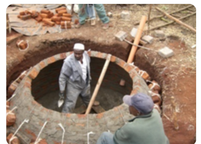
Bau von Biogasanlagen für Haushalte in Kenia
